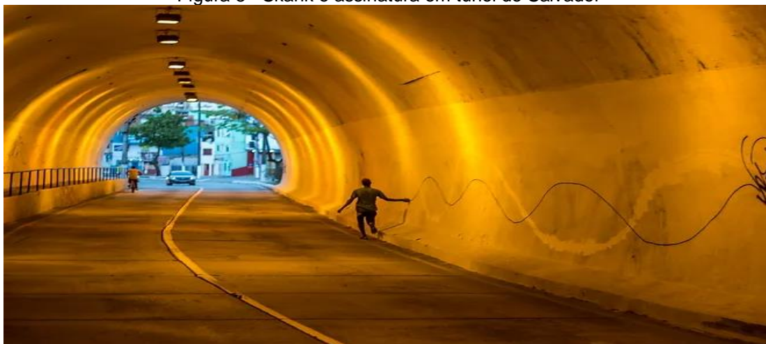
Figura 8 - Skank e assinatura em túnel de Salvador
